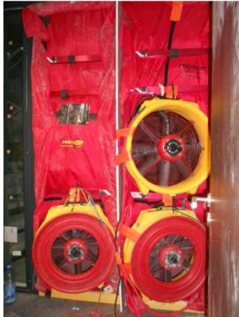
Ventilateurs sur une fausse porte
