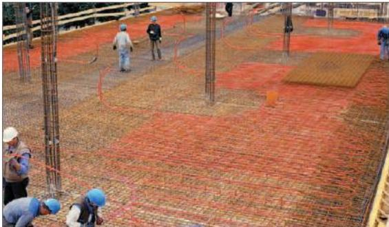
Un principe de dalle active est basé sur l'utilisation au maximum de l'inertie (par la dalle béton dans lequel les tuyaux sont encastrés) permettant des variations de températures lentes et douces. Les régimes de température de l'eau qui circule dans ces tuyaux sont très proches de la température ambiante, c'est à dire très bas en hiver (25°C) et hauts en été (20°C).
