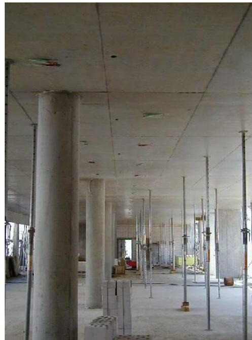
La ventilation est encastrée avec une bouche de soufflage et une bouche de reprise en plafond. Le câblage électrique se fait via le plancher avec des boîtes de sol encastrées.
